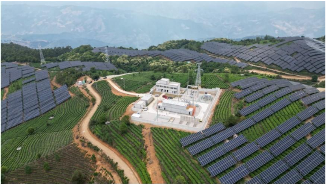
图 2-7 同类茶光互补项目光伏阵列区安装完成示意图
