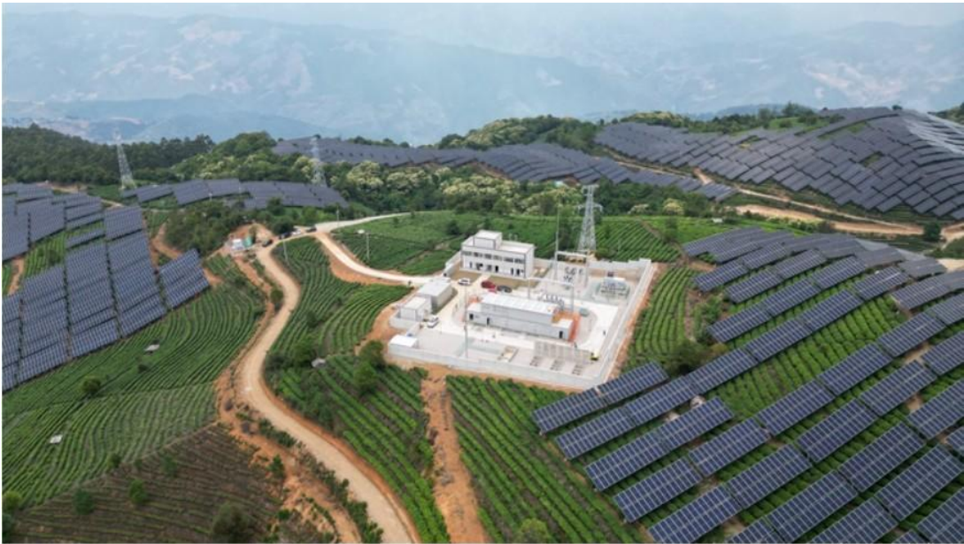
图 2-7 光伏阵列区安装完成示意图
