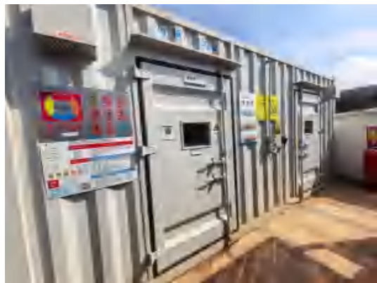
危险废物暂存间（外部）
