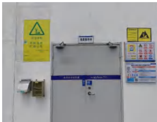
危险废物暂存间（外部）
