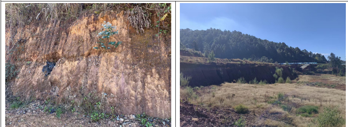
项目区岩性结构（上部人工堆渣及洪积层，原地残积含沙砾红黏土层）
