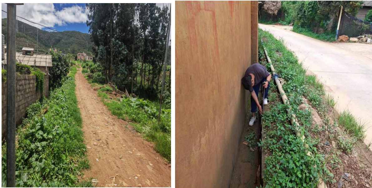
照片 5-1 左为碎石路、右为硬化后道路
