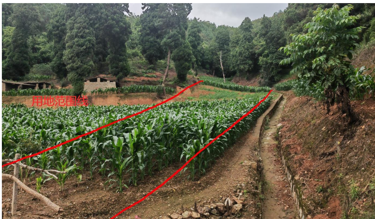
照片 3-1 沿田坝区布设管线地貌
