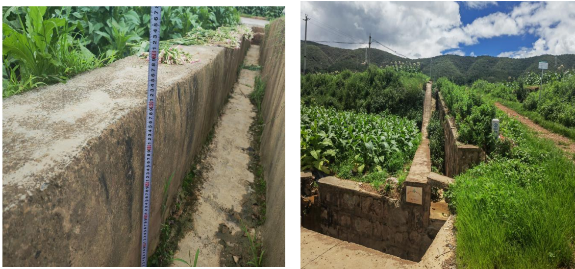
照片 5-2 浇筑沟渠
