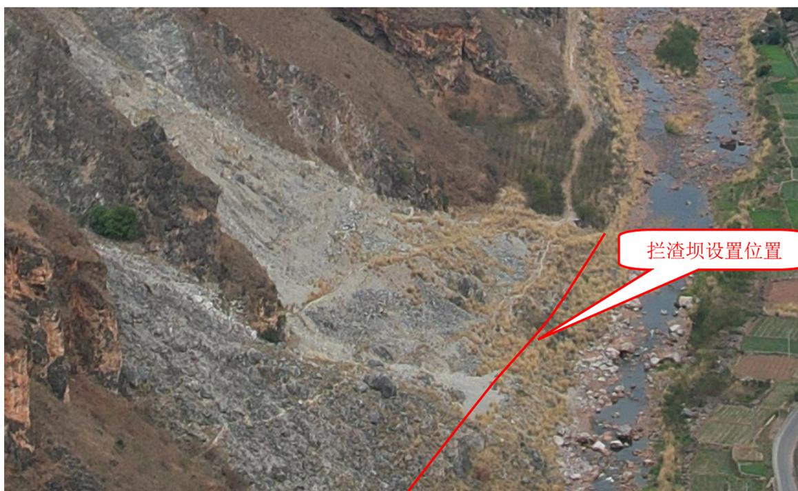
照片 5-1 BW<sub>1</sub> 不稳定边坡挡墙设置位置照片
