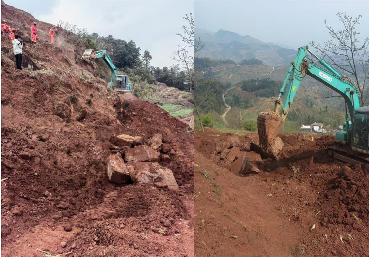
3月14日8时00分，按照既定方案，组织施工人员进场开展处置作业，为确保整个施工过程安全，在巨石下方开挖两个防护沟槽，不让一点碎石和沙土往下流动。经过近4个小时施工作业，成功将巨石取下并转移到安全区域，通过深埋处理，全面排除安全隐患。
