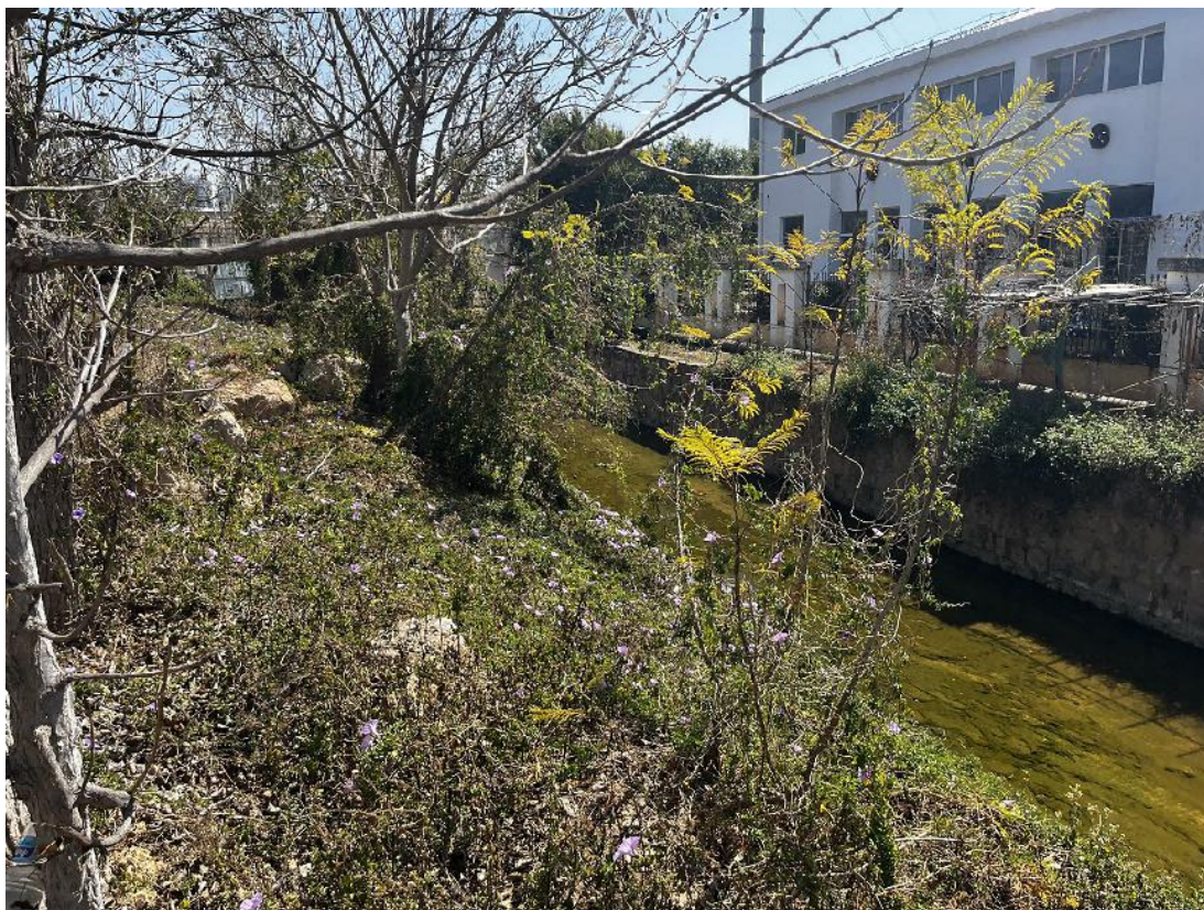
照片 4-3 临时用地周边中心沟现状
