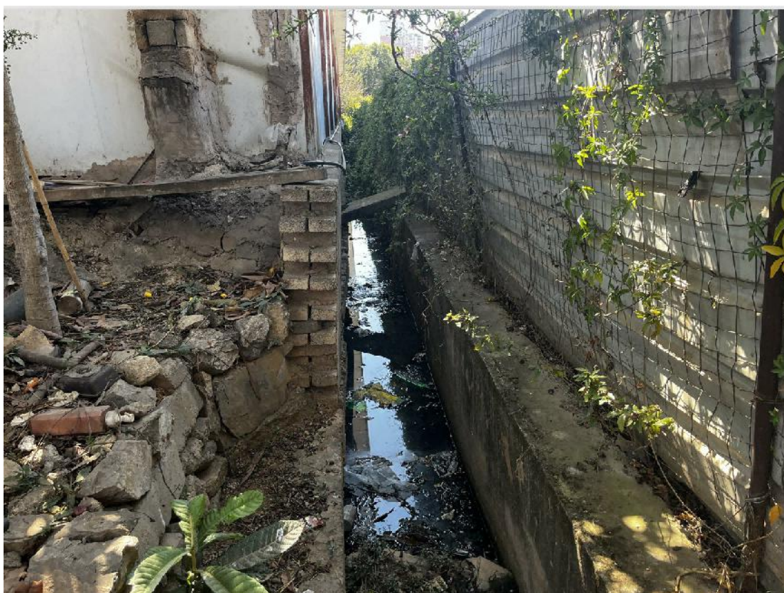
照片 4-2 耕地区周边排水沟现状
