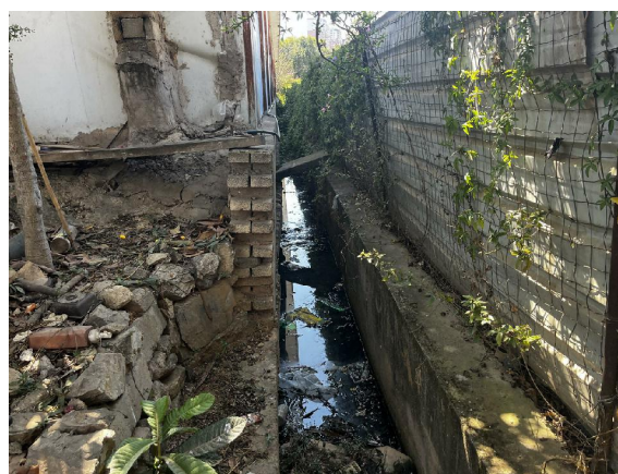
照片 4-20 耕地区周边沟渠现状
