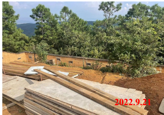
项目站址现状
