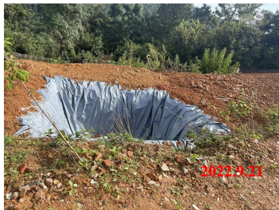
项目站址临时沉淀池
