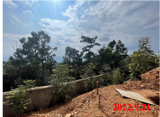
项目站址北侧现状
