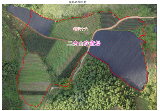
(地块十八) 二尖山弃渣场
