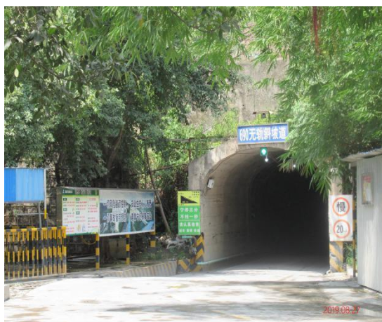
无轨斜坡道（利用）
