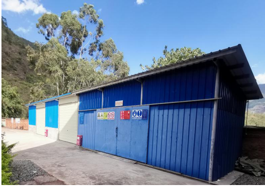
危险废物暂存间
