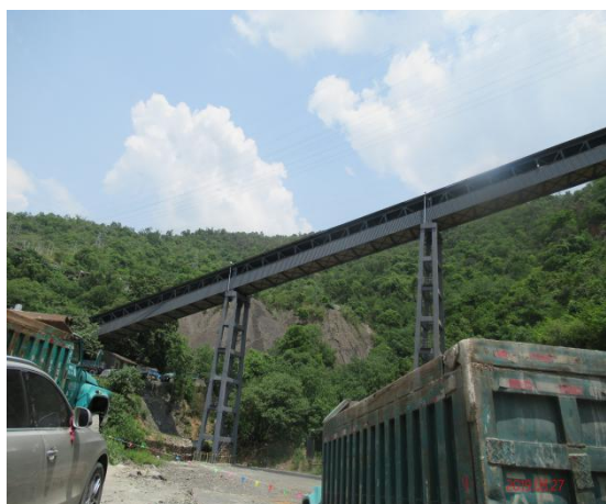
主斜井及运矿栈道（利用）
