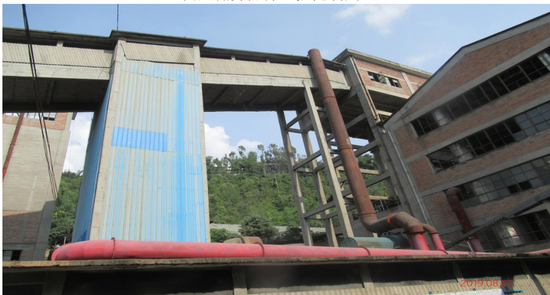
一选厂矿矿仓及运矿栈道（依托利用）
