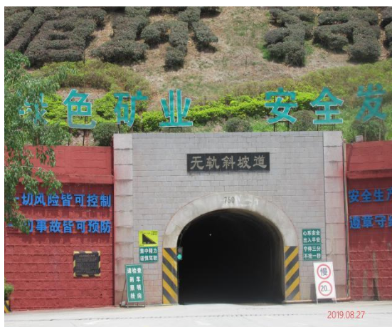
无轨斜坡道（利用）
